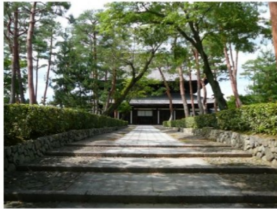
写真① 相国寺本堂（法堂）（国指定重要文化財）
